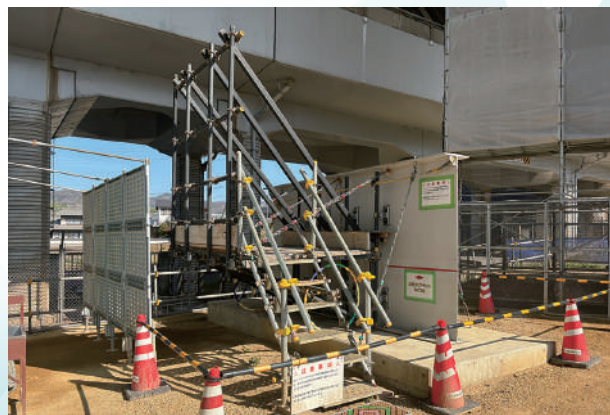
現場で試験体を設置し、検証を実施
